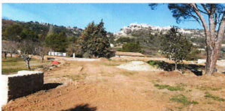
Portion du chemin rural située à l'ouest de la Bastide Neuve constituant l'accès à la propriété CARRIER
