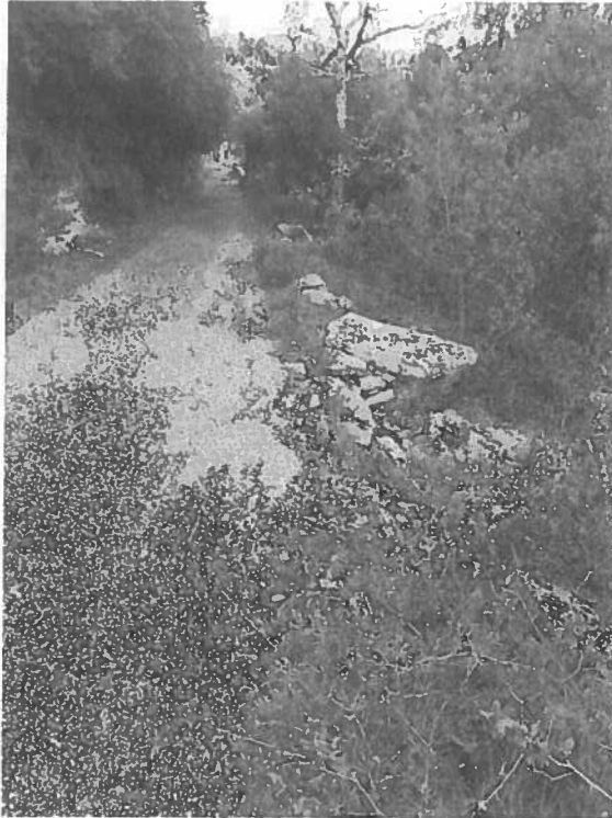
Partie du chemin de la Gacholle, prolongeant celle objet de l'enquête publique, conduisant à la ferme de la Gacholle : voie étroite, mauvaise qualité du revêtement, terrain faiblement stabilisé
